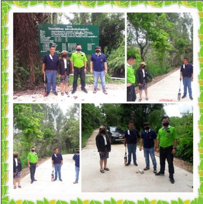
โครงการก่อสร้างถนน คสล.ซอย 3 หมู่ 12
