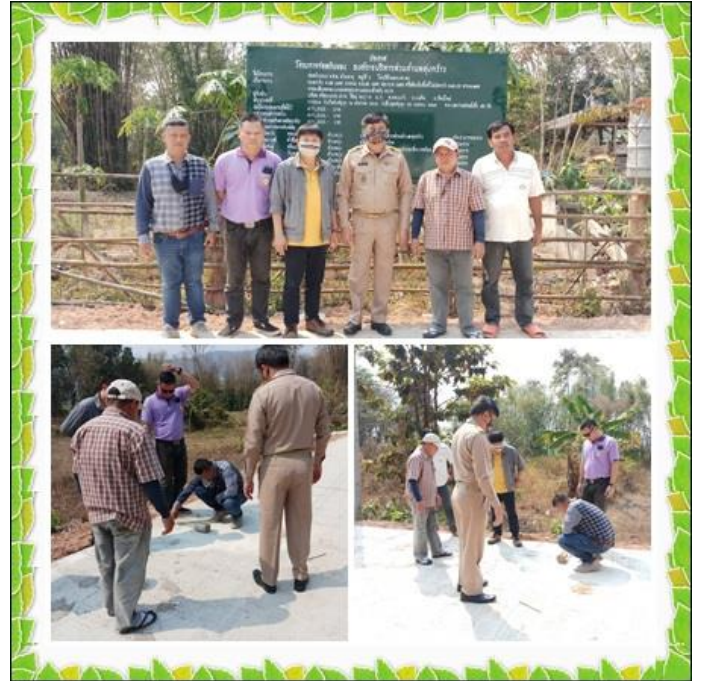
โครงการก่อสร้างถนน คสล.ห้วยชาติ หมู่ 3
