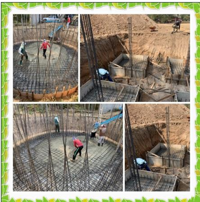
โครงการก่อสร้างประปา หมู่ 3
